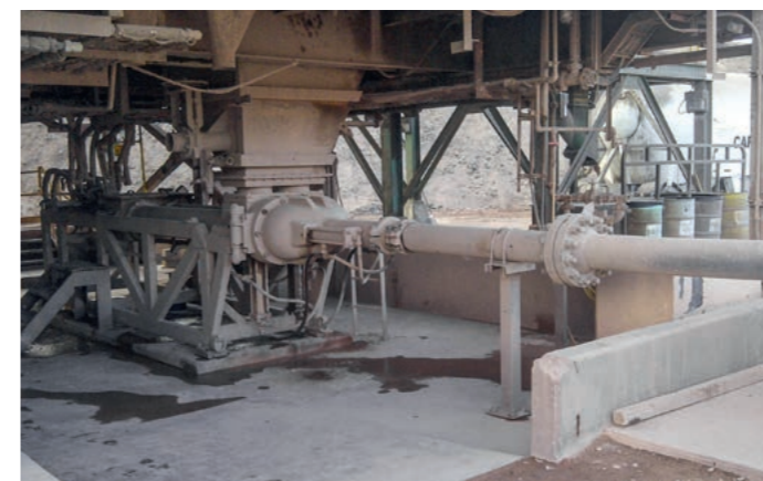
Remblayage de mines (Ocambo, Mexique)
