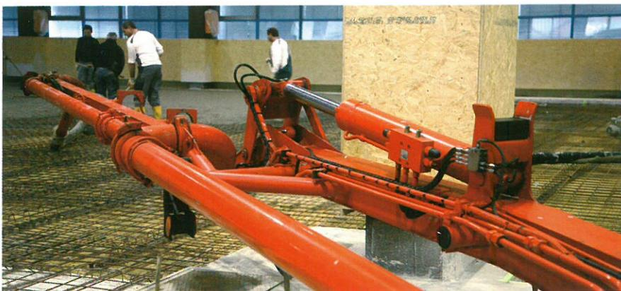
En position de travail, tous les vérins hydrauliques de la flèche sont au dessus des bras. Ceux-ci sont protégés des chocs et toutes projections de béton.
