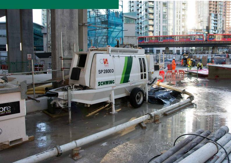
Débit max. 112 m³/h Pression de pompage max. 108 bar
