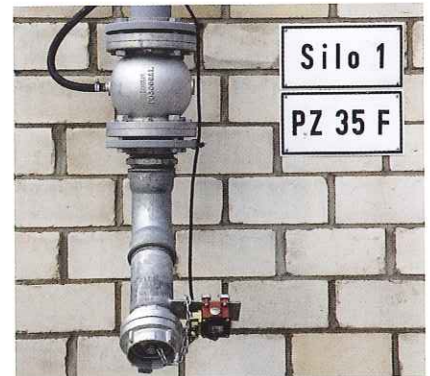
La protection contre le surplein de liant est conforme aux critères UVV. Le robinet-vanne à manchon déformable empêche, avec un dispositif facultatif de surveillance de pression, une surpression du silo de liants.
